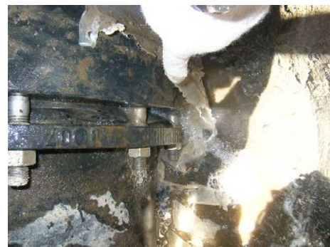
■被覆管 ・埋設深2500 ・φ600 ・フィルム1本巻
